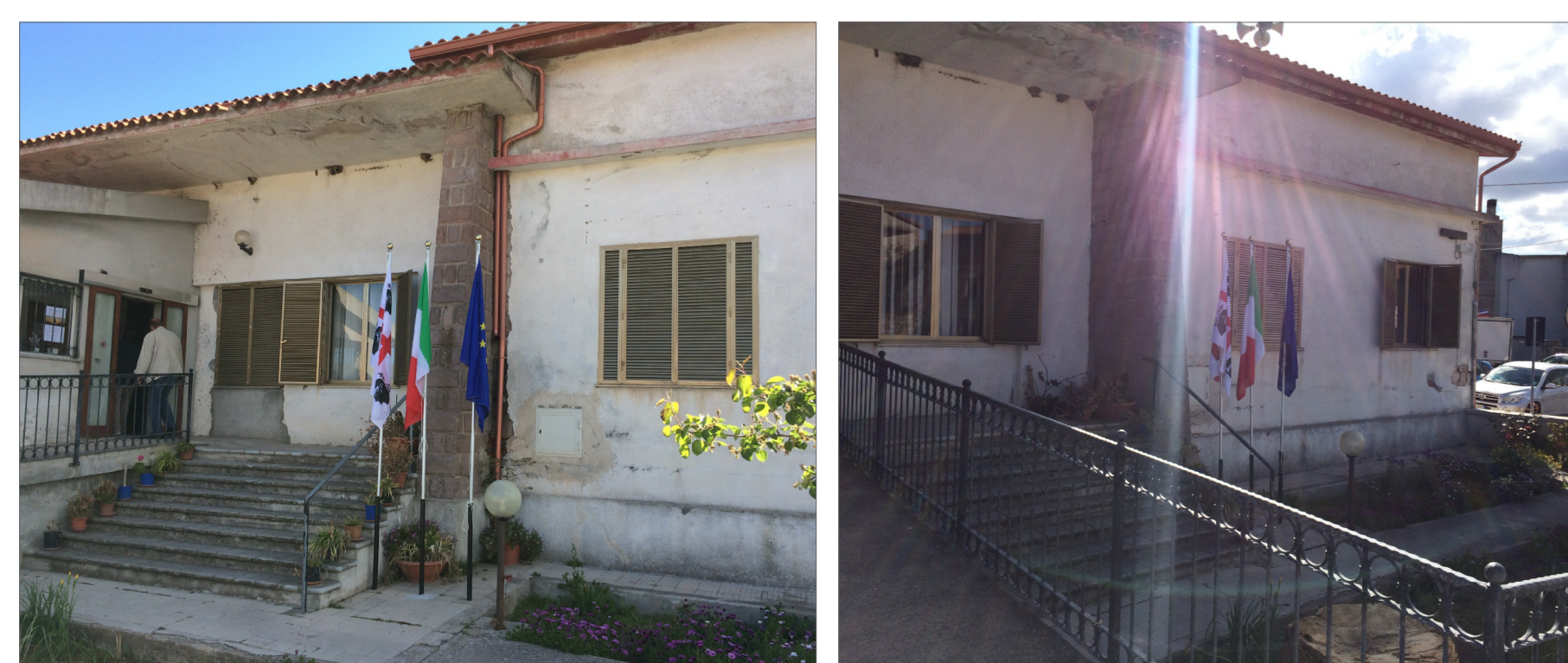
Prospetto ovest- Fenomeni di erosione e esfoliazione degli strati di finitura con messa a nudo della muratura sottostante
