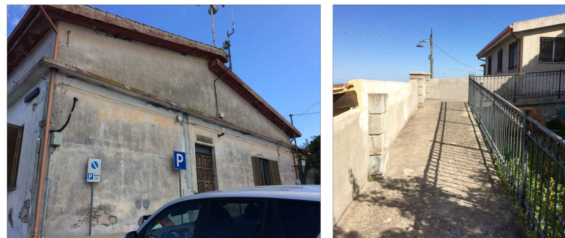
Prospetto ovest- Fenomeni di erosione e esfoliazione degli strati di finitura con messa a nudo della muratura sottostante
